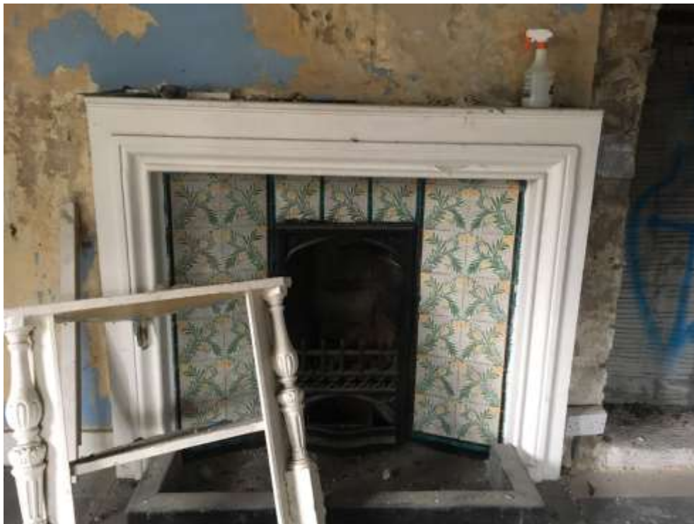
Image F1 (3) – First floor -Room F1
