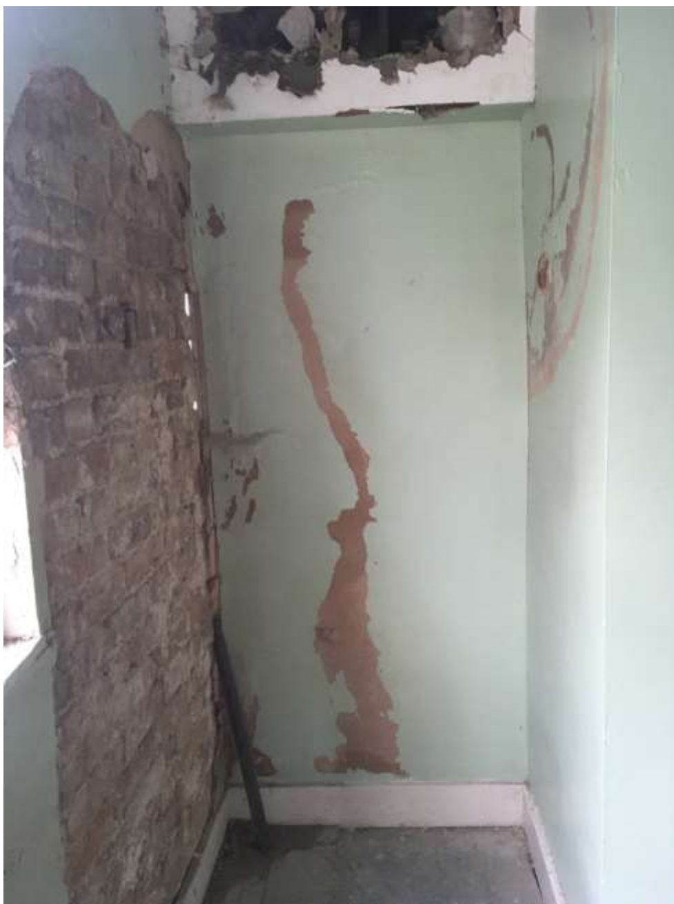
Image F1 (1) – First floor -Room F1
