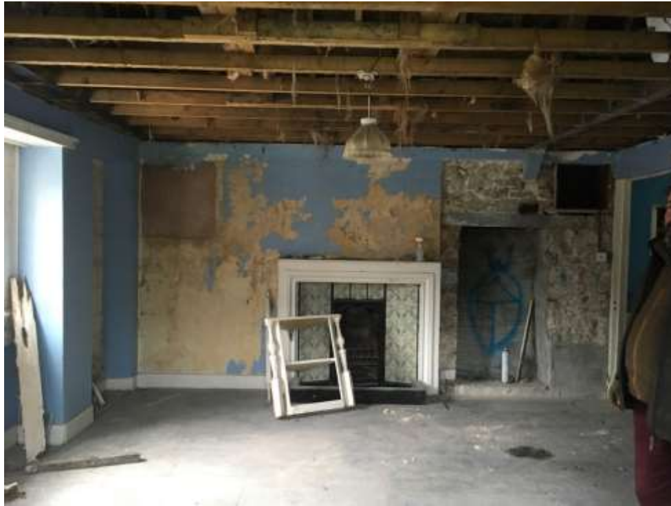
Image F1 (2) – First floor -Room F1
